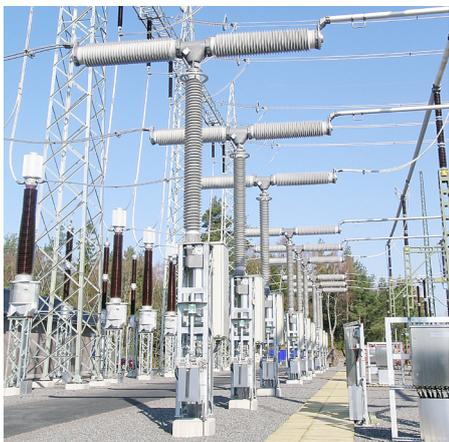
Interruptor seccionador de SF<sub>6</sub> de 420 kV
