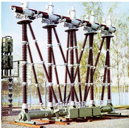
Interruptor de aire comprimido de 420 kV
